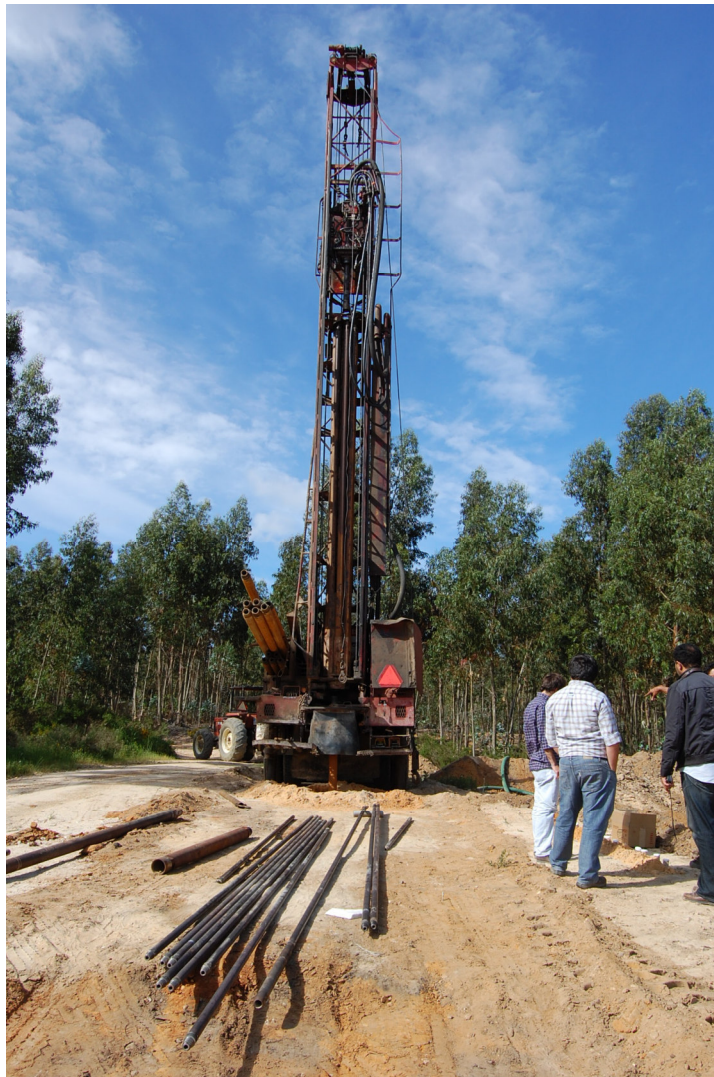
Equipamento de Sondagem
